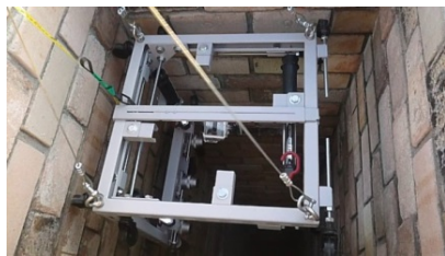
図7 煙突内部撮影用治具及び撮影状況
