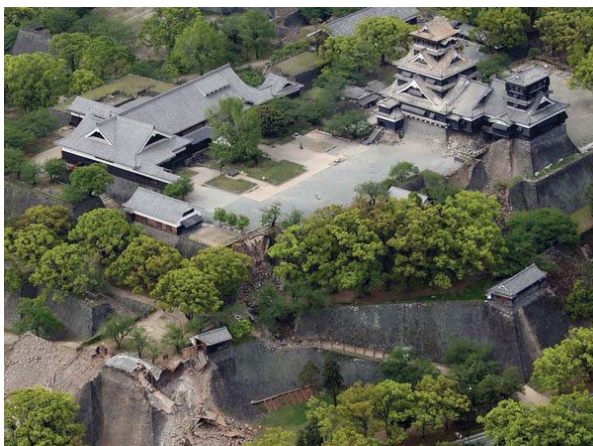
図3 樹木に覆われた熊本城の石垣 樹木に覆われた石垣面の計測を如何に迅速にかつ精度良く計測するかが鍵
