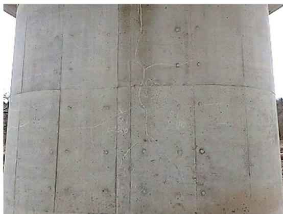
図-1 橋脚のひび割れ状況
