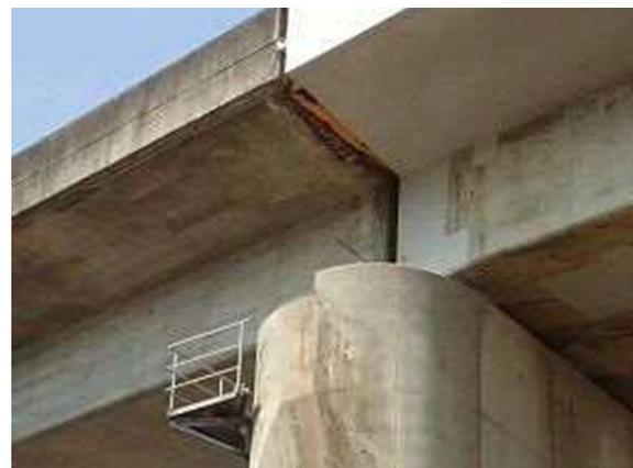
図-3 鉄筋露出
