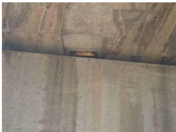
図-4 ローラーカバーの腐食
