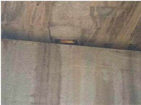
図-1 支承の腐食が観察された例
