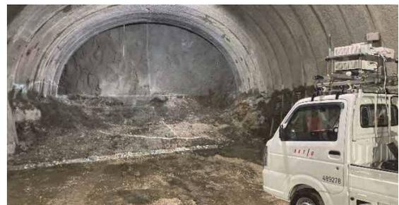
写真-2 3D計測機器設置
