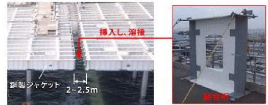
図-7 ジャケットの据付状況
