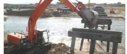
写真3 橋脚載荷重状況
