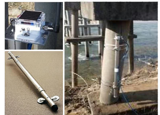
写真2 センサー取付状況
