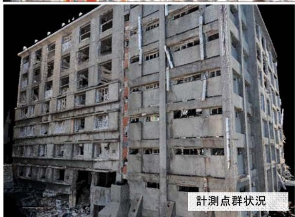
図4 3Dレーザ計測状況と点群表示(30号棟)
