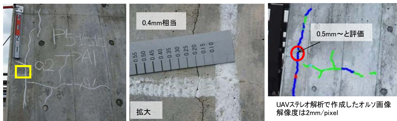
図26 擬似オルソ画像によるひび割れ幅算定結果
