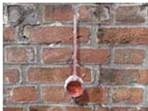
注水器で原爆ドーム壁体の防水性を確認
