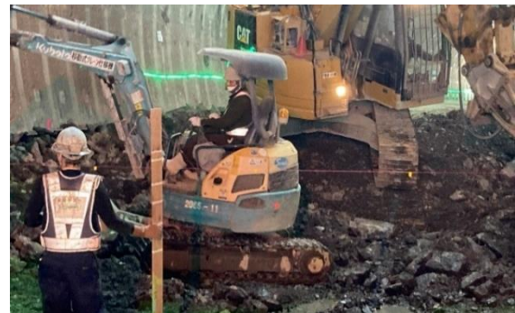
写真-1 インバート掘削状況
