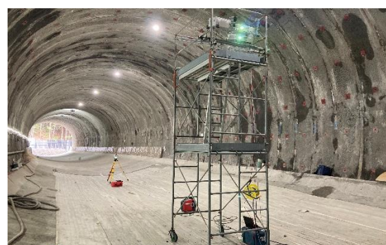
写真-2 3D 機器設置状況
