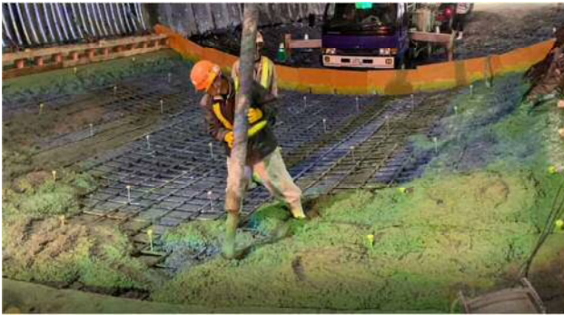
写真-2 コンクリート打設時投影状況
