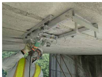
スリット切削状況
