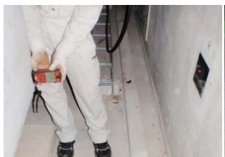
クリアランスの計測状況
