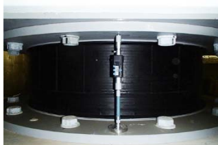
積層ゴムの変位計測状況
