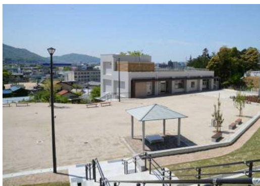
広島市豪雨災害伝承館
