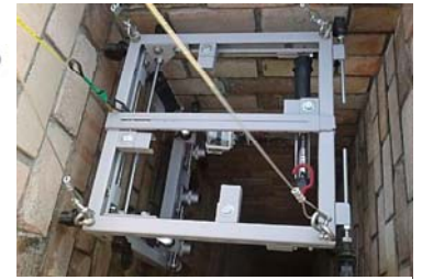
図7 内壁撮影状況
