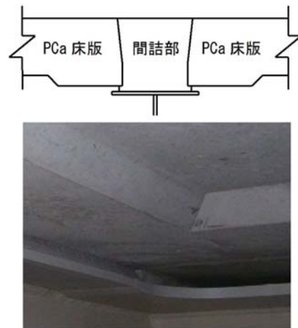
図-1 間詰部の状況
