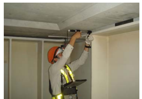
写真-4 点検の状況
