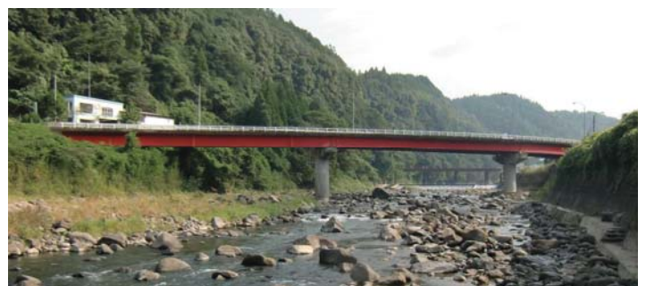
写真-1 対象橋梁全景
