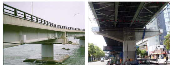
写真-2 外ケーブル補強工法実施橋梁
