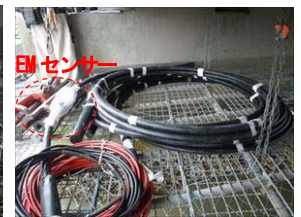
写真-6 搬入時ケーブル
