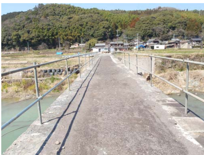
写真-2 復旧後（橋面）
